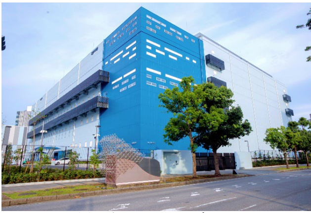
サーバー設置予定の NRT10 データセンター
